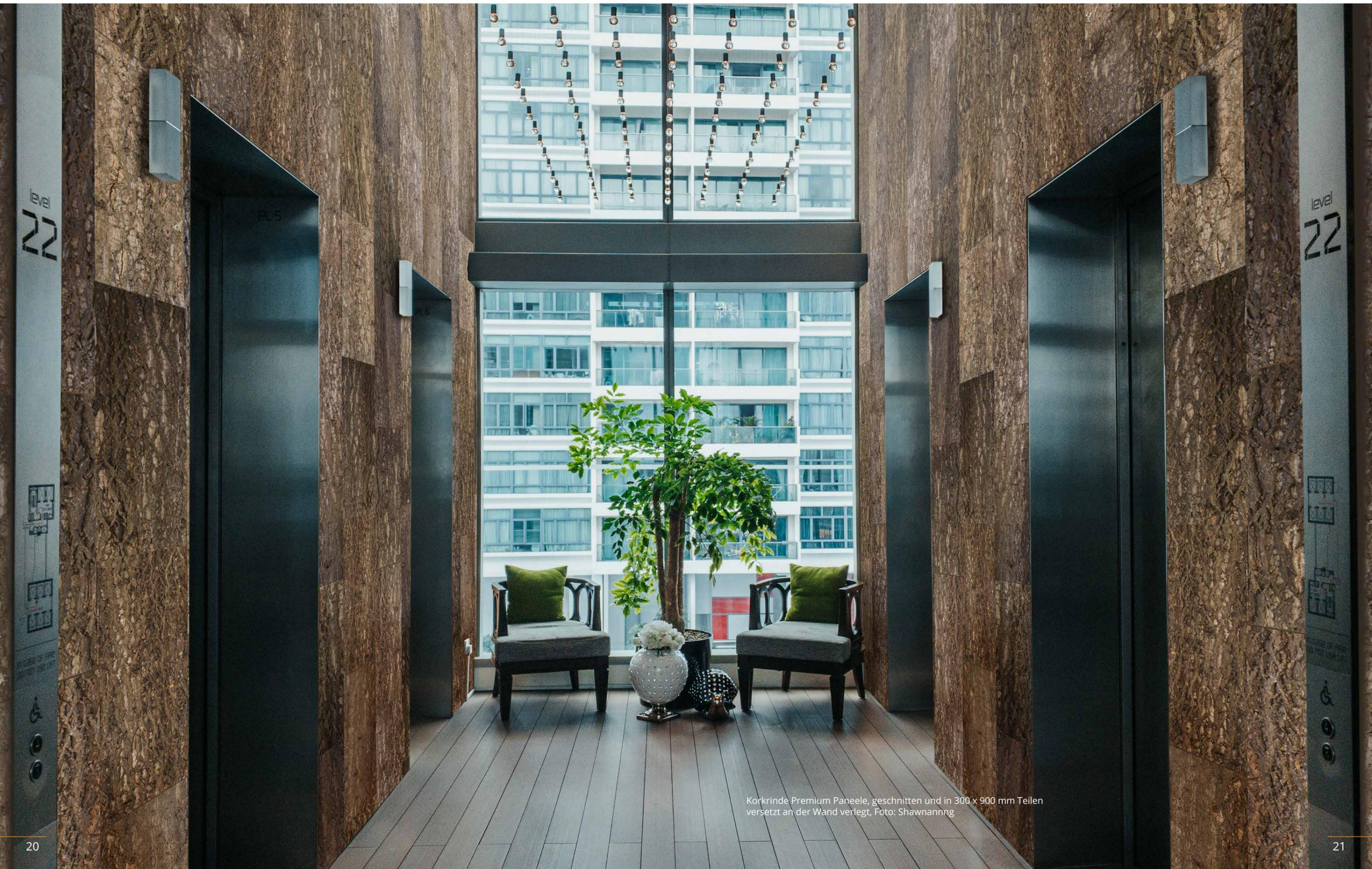
Korkrinde Premium Paneele, geschnitten und in 300 x 900 mm Teilen versetzt an der Wand verlegt, Foto: Shawnannng
