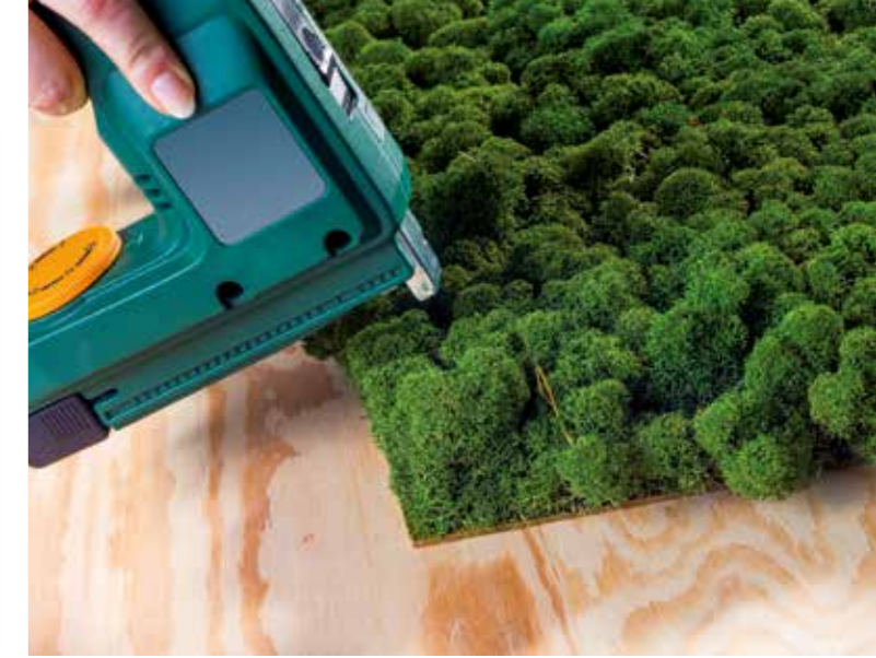
Die Moosplatten können mit einem (z. B. elektrischen) Tacker auf einem Holzuntergrund befestigt, verschraubt oder direkt verklebt werden, Foto: KOMPE IMAGES
